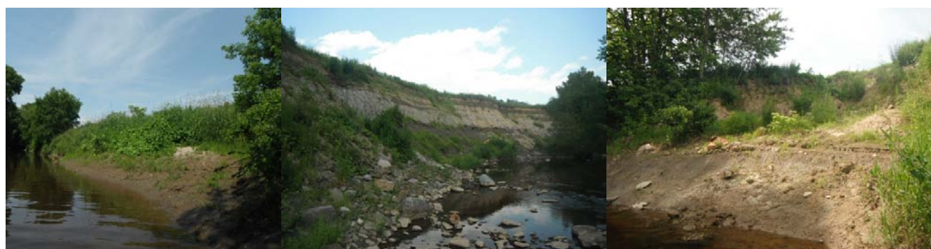
Figure 9 : Photographies de l'érosion des berges en zone agricole, partie aval de la rivière du Bois Clair (juillet 2011)
