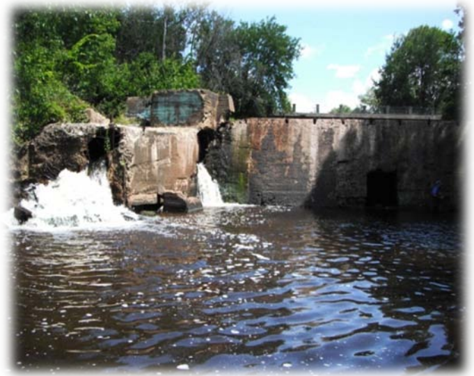
Figure 30. Barrage infranchissable de Val-Alain
